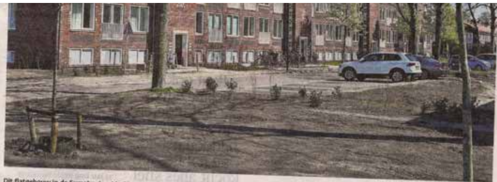
Dit flatgebouw in de Sumatrastraat is één van de flats in de Indische Buurt die recent werden gerenoveerd door Pré Wonen.
